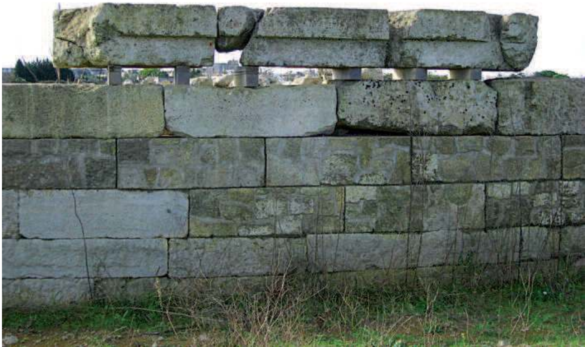
Vaste. Ricostruzione di un tratto di mura messapiche. Foto: M. Piccinni
